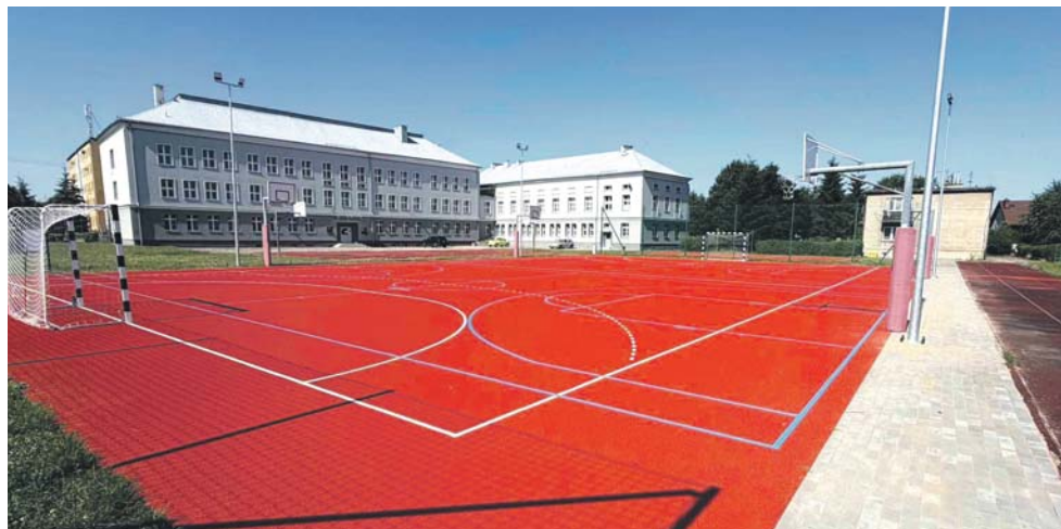
Boisko wielofunkcyjne przy SP nr 21 na Jęzorze przeszło gruntowną modernizację.
