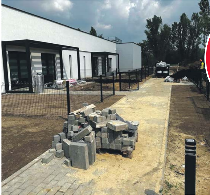
Przy budynku trwają jeszcze prace związane z aranżacją terenu.
