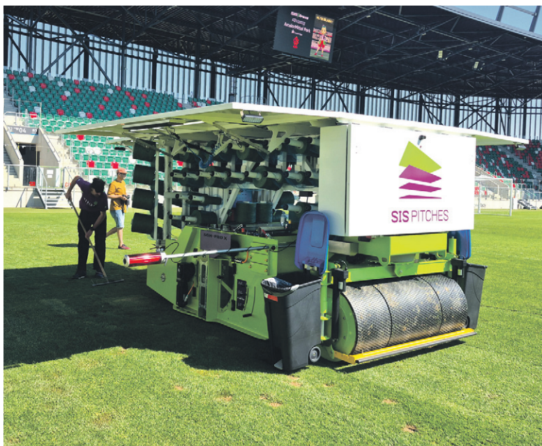
Maszyna wbija sztuczne włókna na głębokość 145 milimetrów.
