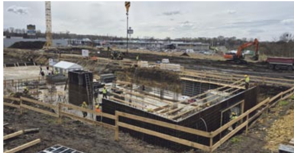
Na placu budowy nowego osiedla praca już wre.
