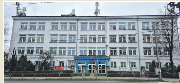
Wśród placówek, które przejdą termomodernizację, będzie Szkoła Podstawowa nr 20 przy ul. Andersa.
