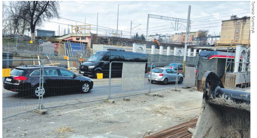
Przejazd pod wiaduktem będzie zamknięty już po raz ostatni.
