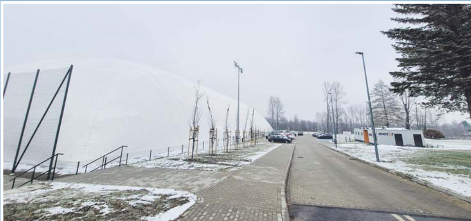
Obok boiska powstały również szatnie i miejsca parkingowe.
