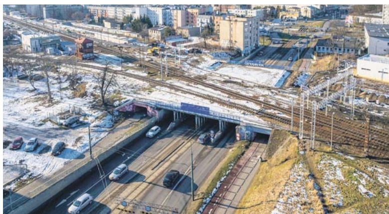
Wiadukt w centrum miasta musi być przebudowany ze względu na jego stan techniczny.
