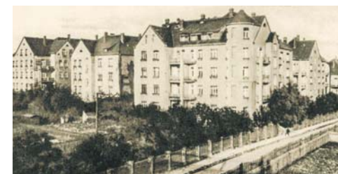
Kolonia „Ficnerowska” przy ul. Szpaków (dawniej ul. Gołębia) powstała w latach 20. XX w. dla urzędników oraz nadzoru technicznego fabryki. W pobliżu znajduje się również willa dyrektora Jechalskiego – obecnie Przedszkole Miejskie nr 2. Druga patronacka kolonia znajdowała się w rejonie obecnej ulicy Fitznera i Gampera. Arch. UM Sosnowiec.
