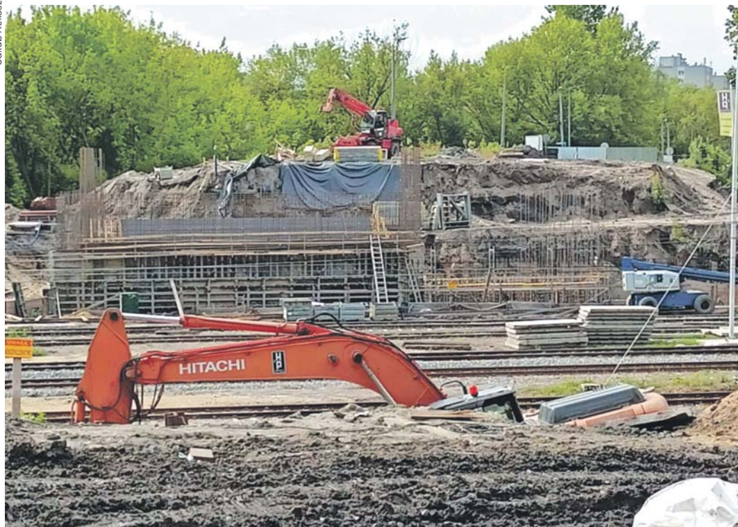
Wykonawca prac zajmuje się aktualnie budową przyczółków i filarów.
