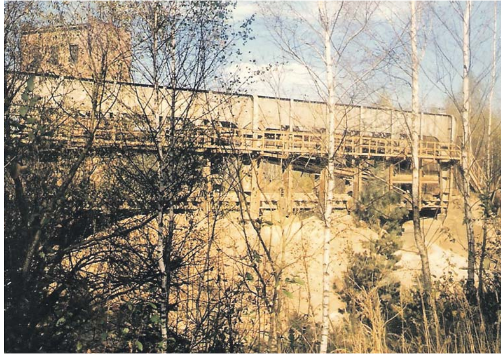
Most zsypany nad muszlą zamkową szybu „Leśnego”. W tle widoczna jest wieża szybowa typu basztowego. Zdjęcie z przełomu lat 80. i 90.
