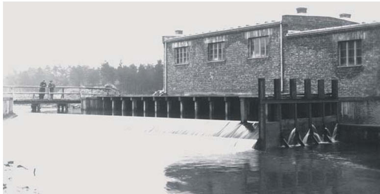
Ujęcie wody w Ryszce oddano do użytku w 1937 roku. Obiekt ostatecznie został zlikwidowany w 2021 roku. Ostatni pobór wody miał miejsce w styczniu 2004 roku. Skan zdjęcia udostępnił pan Jakub Leksowski – SUW Maczki.
