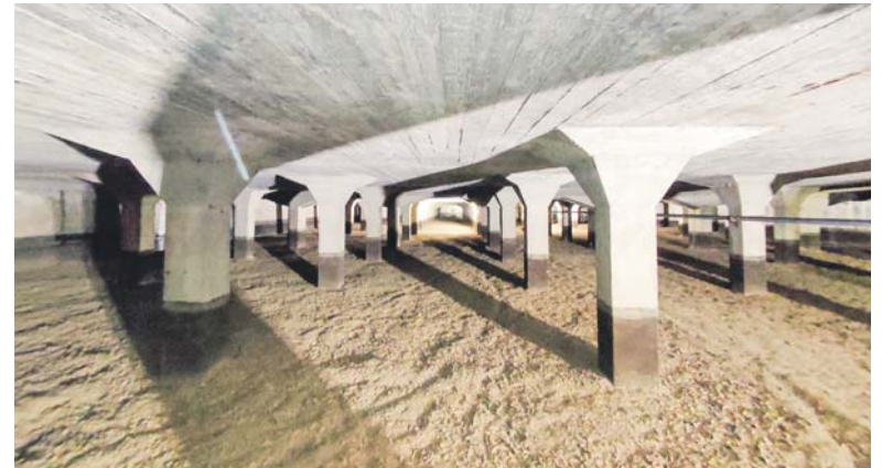
Oddane do użytku w 1931 roku filtry powolne (od ponad czterdziestu lat nieczynne) stanowią wspaniały zabytek inżynierii wodociągowej.
