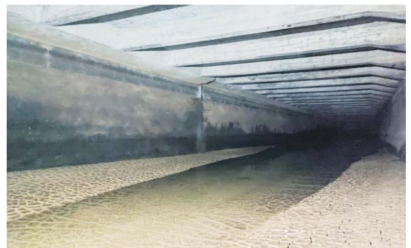
Do odmulnika trafiały osady pochodzące z procesu uzdatniania wody w filtrach powolnych. Obiekt od wielu lat jest wyłączony z eksploatacji.
