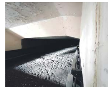
Jeden ze zbiorników znajdującego się pod ziemią kompleksu filtrów powolnych. Obiekt ten jest wyłączone z użytkowania.
