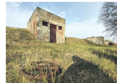
Ziemny nasyp skrywa ogromną żelbetową konstrukcję – filtry powolne z 1930 r.
