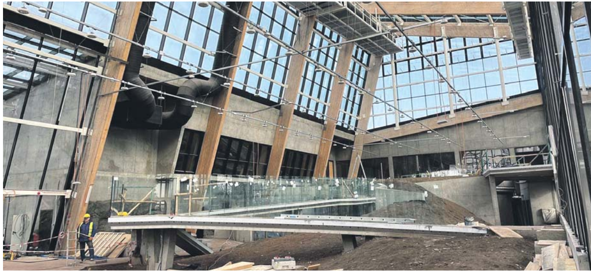
Prace związane z budową Egzotarium toczą się już wewnątrz obiektu.
