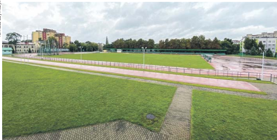
Wartość prac na stadionie to blisko 10 milionów złotych.
