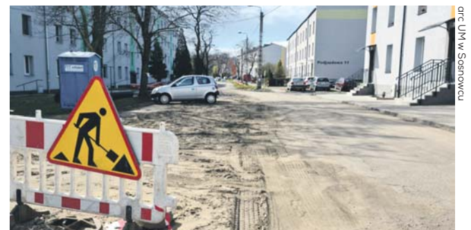
Po wykonaniu prac związanych z kanalizacją zostanie położona nowa nawierzchnia jezdni.
